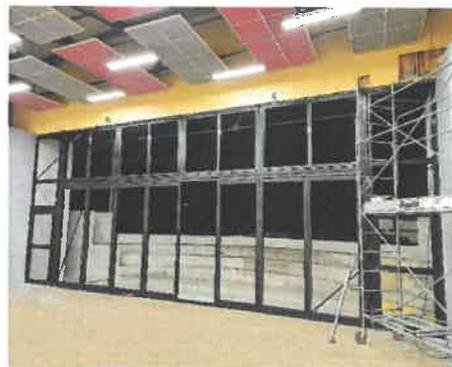
*Remplacement de la porte métallique par un ensemble en menuiserie aluminium*
