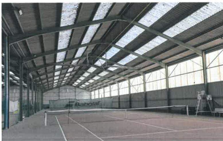
La structure porteuse est composée d'une charpente métallique. Celle-ci est en bon état et nécessite l'installation d'un système de liernes reliant les pannes afin de supporter les charges additionnelles à prendre en compte dans le cadre du projet de création d'une centrale PV (poids du système photovoltaïque + poids des bacs acier de la couverture).
